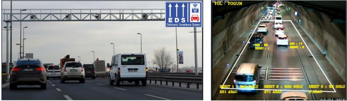
Şekil 1: EDS ve bazı tünellerde bulunan araç yoğunluğunu tespit eden tünel kameraları.
